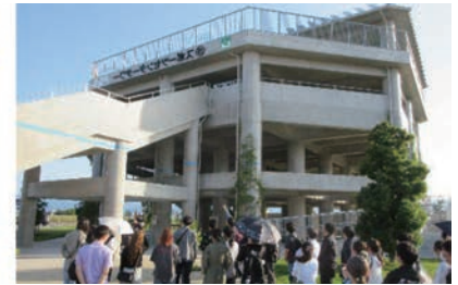
南国市スポーツセンタータワー見学
